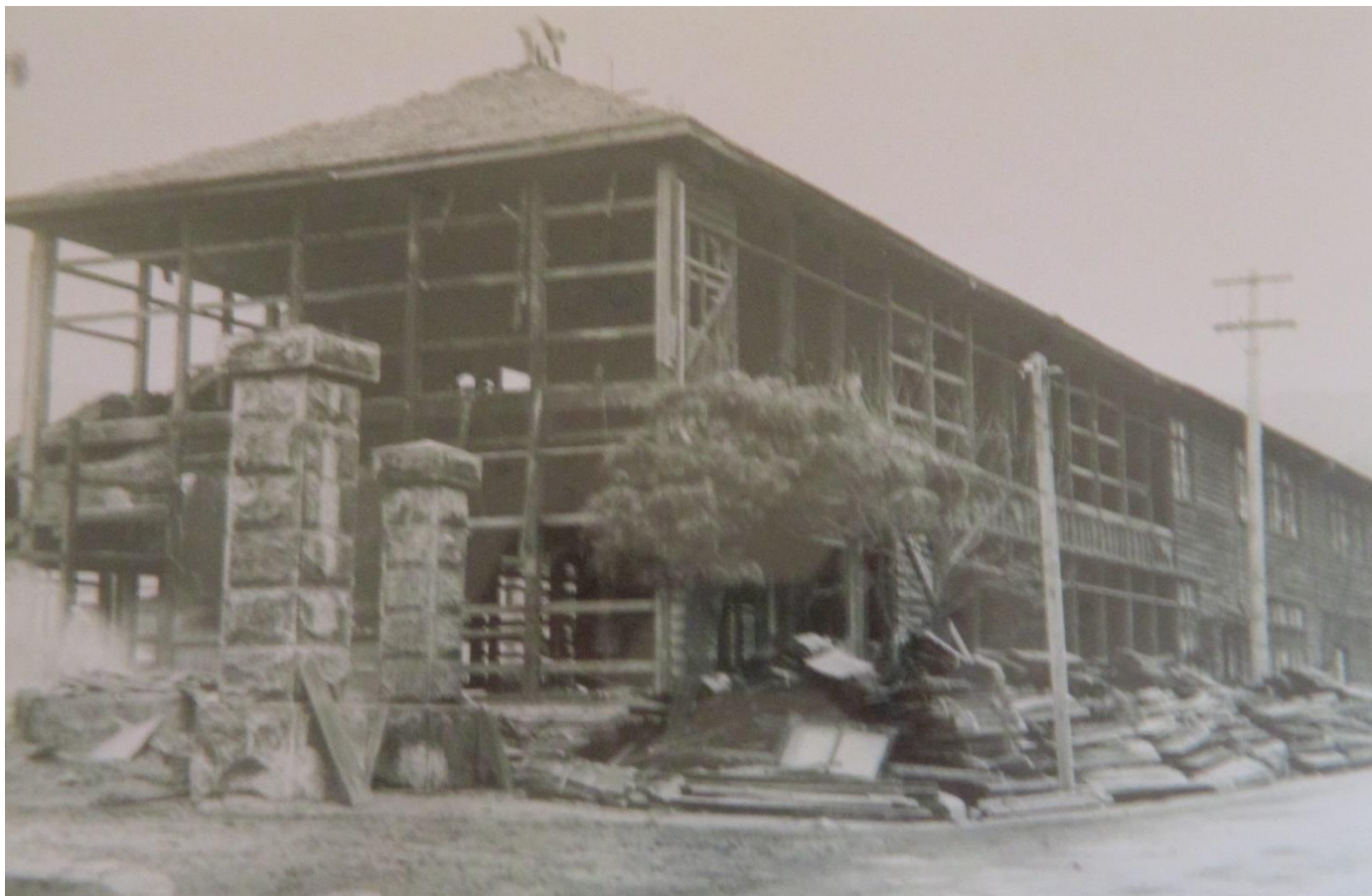
河和田尋常高等小学校校舎取り壊し (昭和38年12月撮影)
